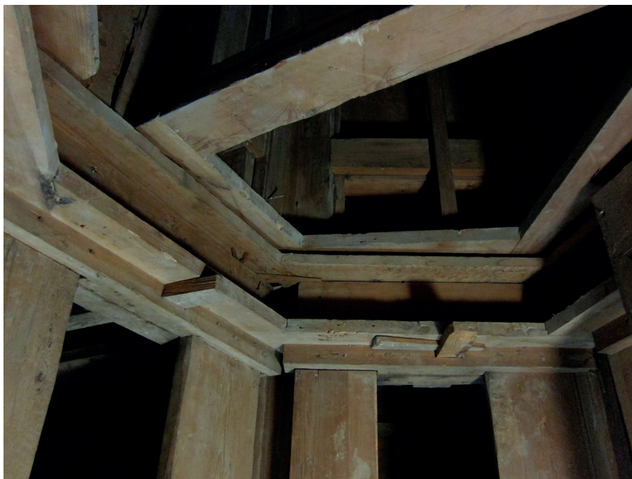
Foto av övergången mellan två konstruktionsmoduler. Här syns ramverket och två historiska kilar som kopplar samman modulerna.
